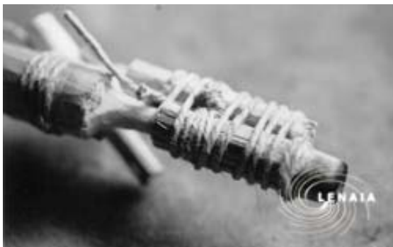
Abb.: Verbindung 1 mit Holunderstück auf dem Dorn (Versuche 1996.1).
